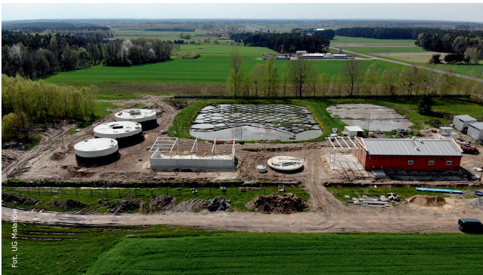
Oczyszczalnia ścieków w Malanowie w trakcie przebudowy
